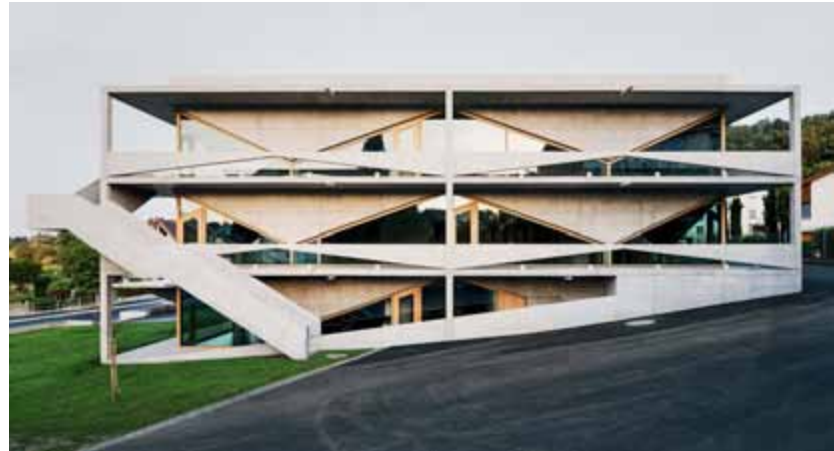
2 Neues Schulhaus Buechen, Thal, 2013, Angela Deuber Architektin, Foto: Schaub Stierli Fotografie.
